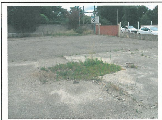
Zone de sondage au droit de l'ancienne station service
