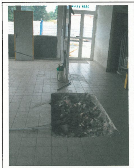
Zone de sondage intérieur du bâtiment A
