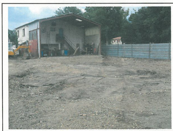
Emplacement du bâtiment C déconstruit en partie
