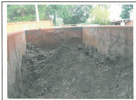
Déchets en benne excavés de l'ancienne fosse maçonnée de brûlage
